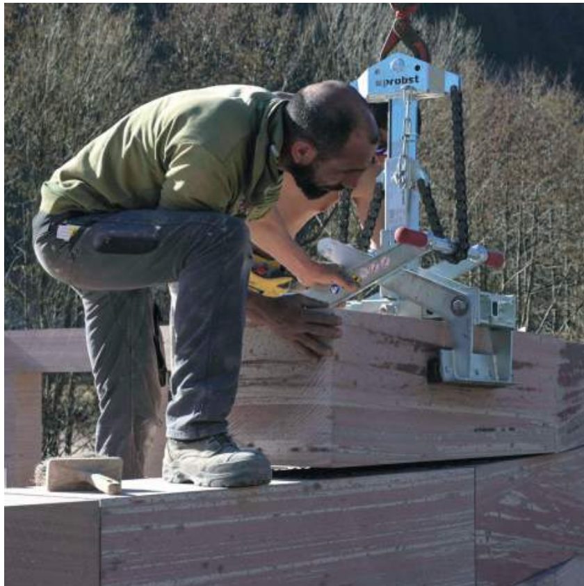
Figure 10. Deux ouvriers ajustent la pose d'un bloc de grès rose sur le chantier de l'Office du tourisme de Plainfaing (88).
