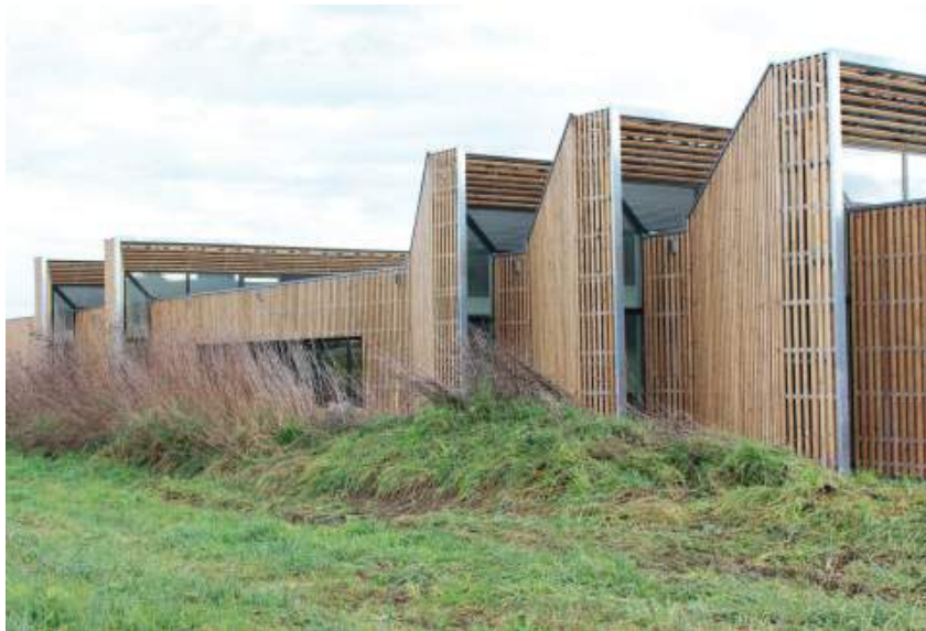
Figure 7. Maison de santé de Void-Vacon (55).
